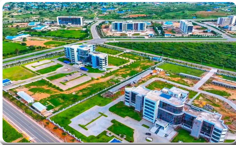
Muonekano wa juu wa mji wa Serikali - Mtumba unaoendelea kujengwa jijini Dodoma.
