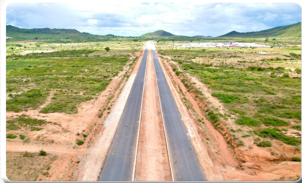
Muonekano wa sehemu ya barabara ya Mzunguko wa nje wa Dodoma (Dodoma Outer Ring Roads) yenye urefu wa kilometa 112.3 inayoendelea kujengwa kwa kiwango cha lami.
